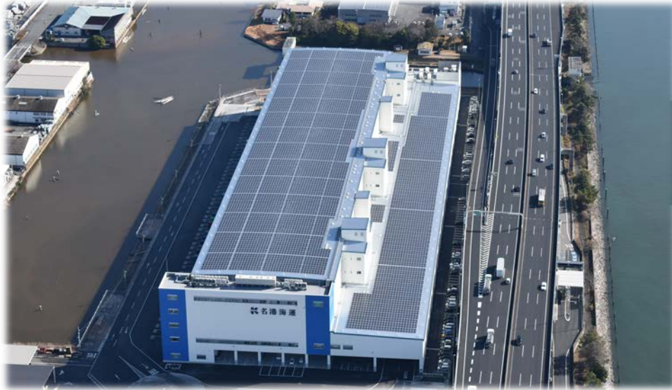
西二区物流センター（南）に設置された太陽光パネル
